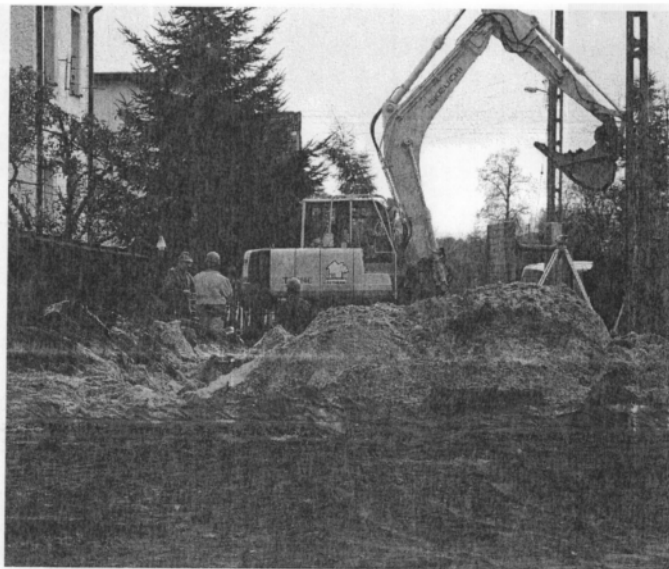
Widać postępujące prace ziemne.
