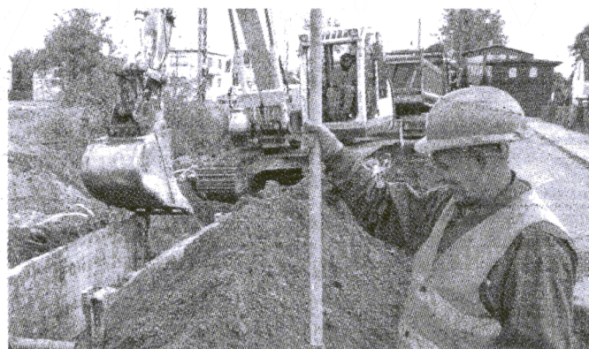
Kanalizacja wsi to część unijnego projektu wartego 100 mln zł.
